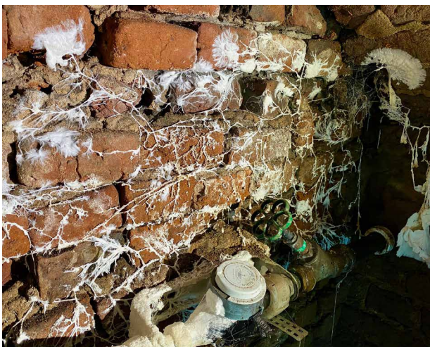
Abb. 1: Eisblumenartige, weiße Stränge, Myzel mit Fruchtkörper an Mauerwerk
