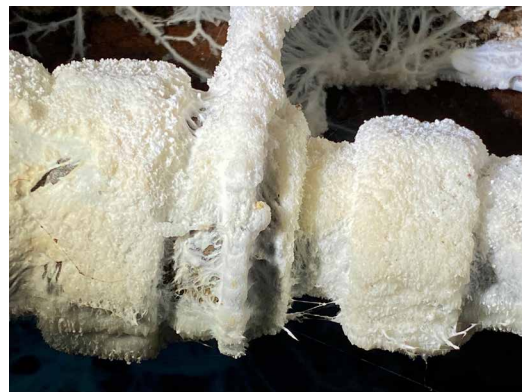
Abb. 3: Ummantelte Wasserleitung mit Fruchtkörper
